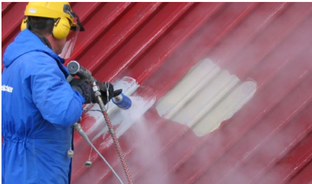
Verf verwijderen met de DYNAJET UHP 220
