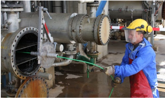
Warmtewisselaar reinigen met de DYNAJET 1000me
